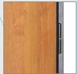
4 Paumelles de 125 mm sur roulement à billes
